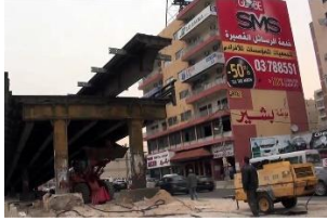
Le démantèlement du pont de Jal el-Dib en 2012. Photo Anne Ilcinkas
