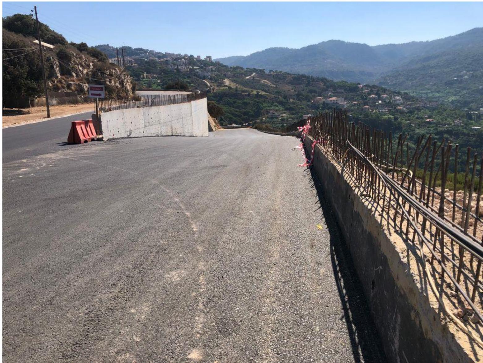
Travaux restants: MC1, couche de revêtement (asphalt wearing coarse), parapets et New Jersey, signalisation et éclairage
